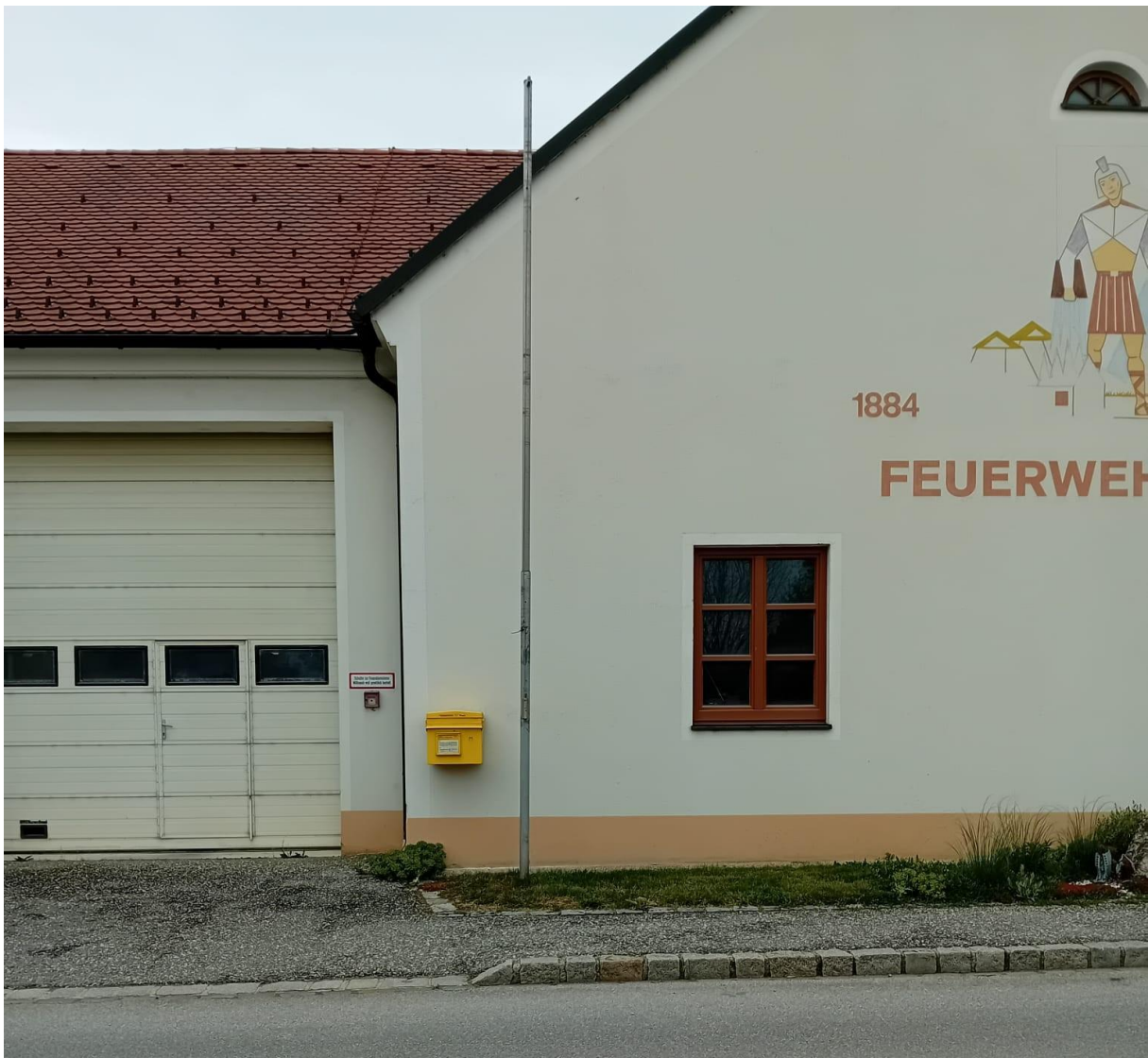
Foto: Neuer Standort FF-Haus Großharras
